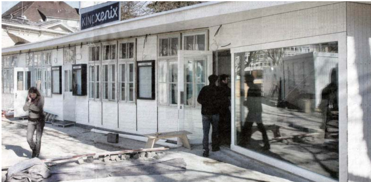
Noch ist nicht alles an seinem Platz, aber es ist deutlich zu sehen: die sanft renovierte Xenix-Baracke erstrahlt in neuer Frische und gefällt mit einem grossen Fenster, das im Sommer komplett geöffnet werden kann. Bild: Dominique Meienberg
