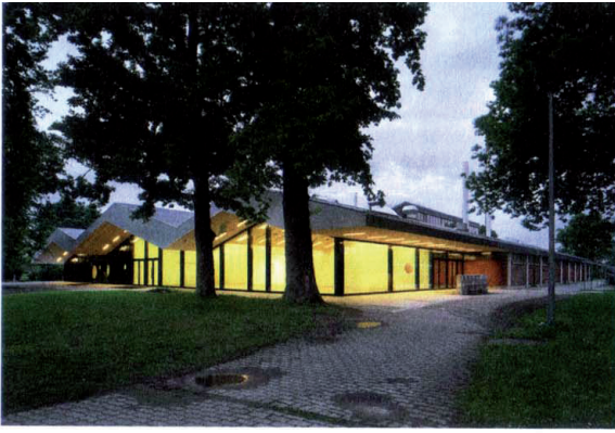
Der zackige Kopfbau in Oberglatt fliesst nahtlos aus dem Bestand.
