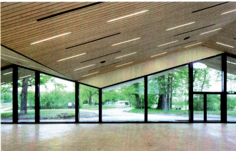
Alles unter einem Dach: Die gefaltete Decke bestimmt den Bau und nimmt die Technik auf.
