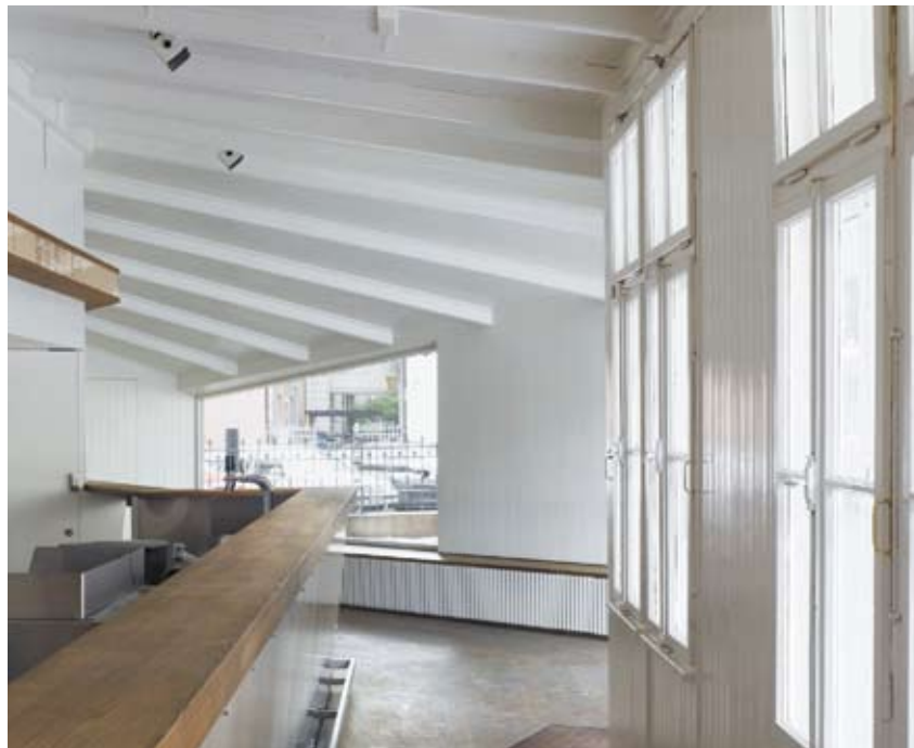
Abb. 11, 12: Die erweiterte Bar ist die auffälligste innenräumliche Neuerung. Die Fächerung der Balken ist äußerst untypisch und ein kleiner Verweis auf deren dekorative Funktion. Foto: Martin Saarinen, Hannes Henz .
