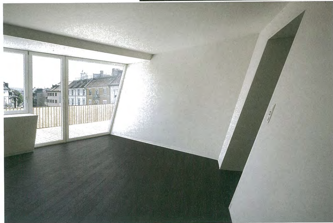
Die ehemaligen Schrägdächer rechts wurden zu geneigten Innenwänden. (Bild: Hannes Henz)
