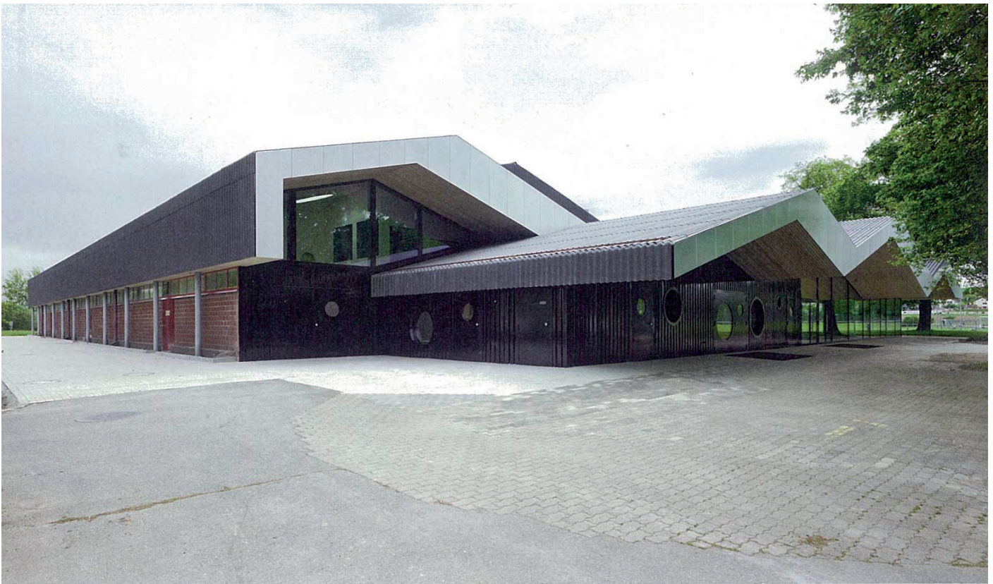
Die alte Halle und der neu gebaute Kopfbau: Das Dach hält alles zusammen. Foto: Hannes Henz
