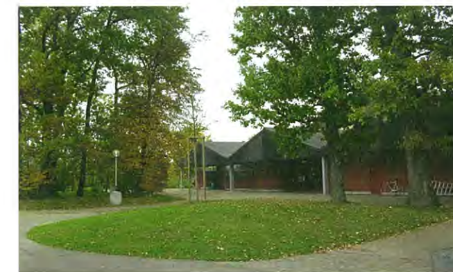
Die Chliriethalle vor dem Brand von 2010
